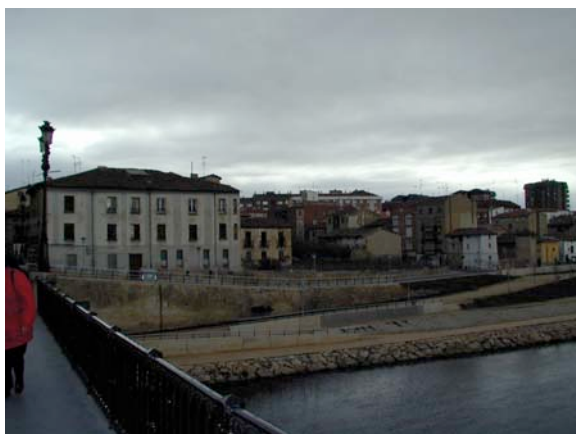
Vista del área del Espíritu Santo desde el puente de Carlos III
